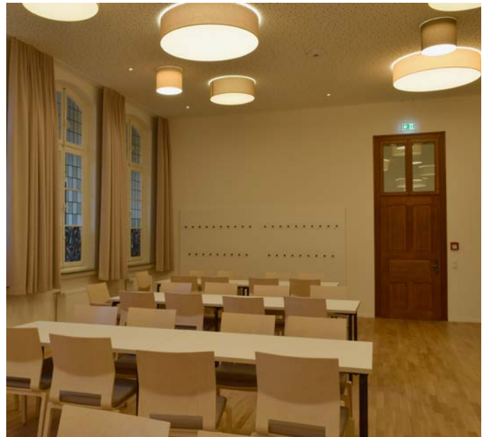
Moderne Tagungsräume mit zeitgemäßer Sicherheitsbeleuchtung Modern conference rooms with contemporary safety lighting
