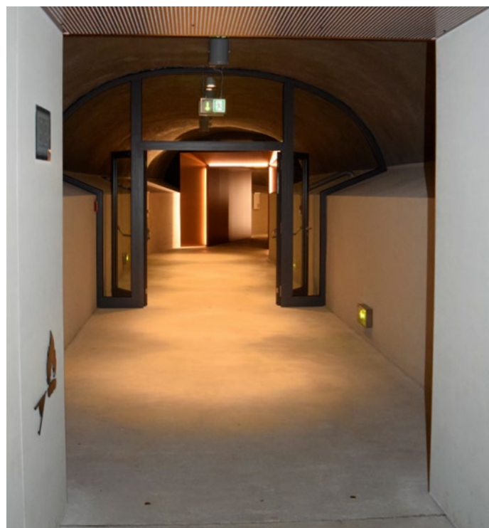
Im Tunnel: bodennahe Richtungsangabe und dynamische Rettungszeichenleuchte im Bereich einer Brandschutztür T30 RS mit Verglasung G30 In the tunnel: low-location direction sign and dynamic emergency exit luminaire near a T30 RS fire door with G30 glazing.
