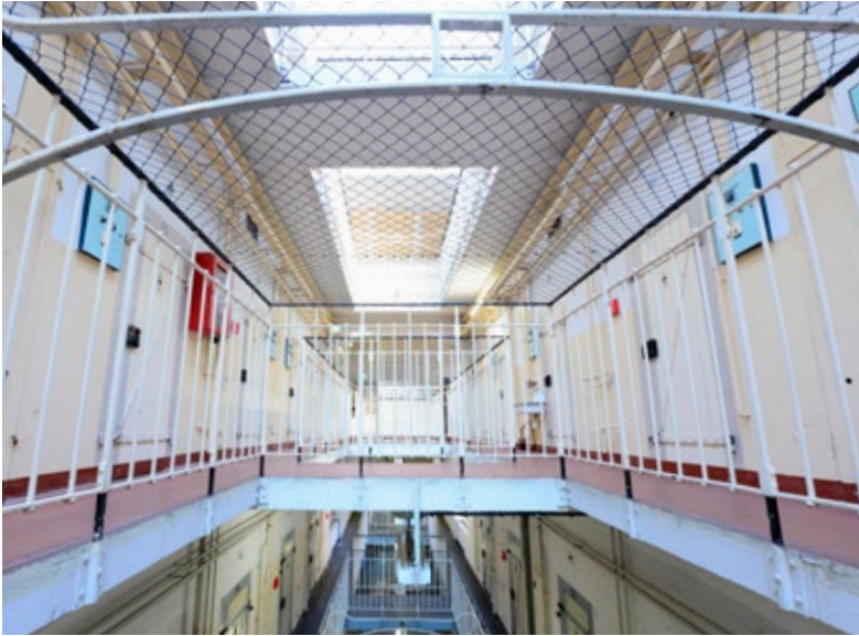
Abb. 3: Der ehemalige Zellentrakt – hier konnten aus Denkmalschutzgründen keine Lautsprecher installiert werden.
