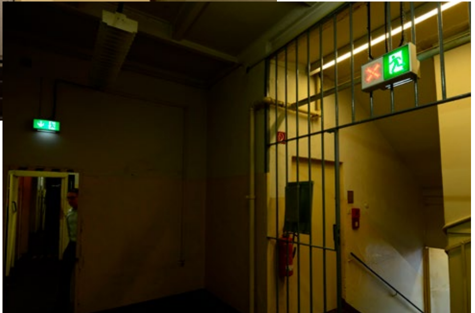
Abb. 6: Im Brandfall sperrt eine dynamische Fluchtwegleuchte optisch Wege in verrauchte Bereiche durch ein rotes, blinkendes Kreuz.
